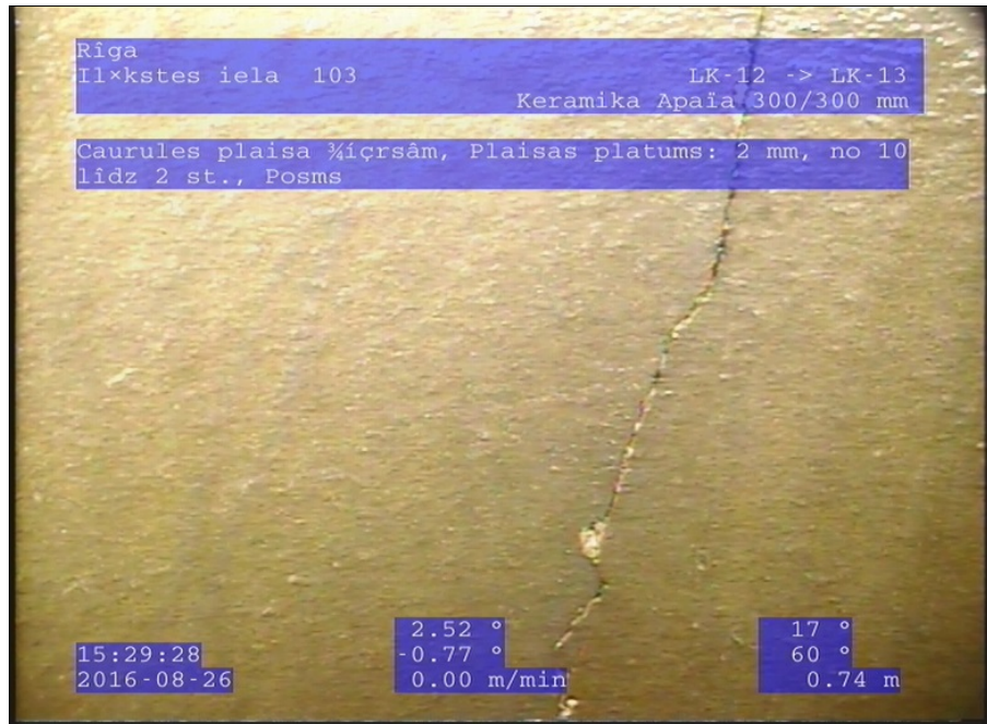
Fotoattēls: 11_3A, 00:00:24 0,74m, Caurules plaisa šķēršām, Plaisas platums: 2 mm, no 10 līdz 2 st., Posms
