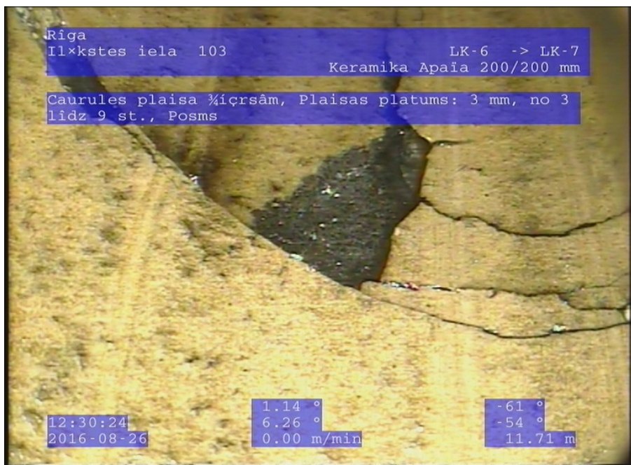
Fotoattēls: 6_4A, 00:01:20 11,71m, Caurules plaisa šķērsām, Plaisas platums: 3 mm, no 3 līdz 9 st., Posms
